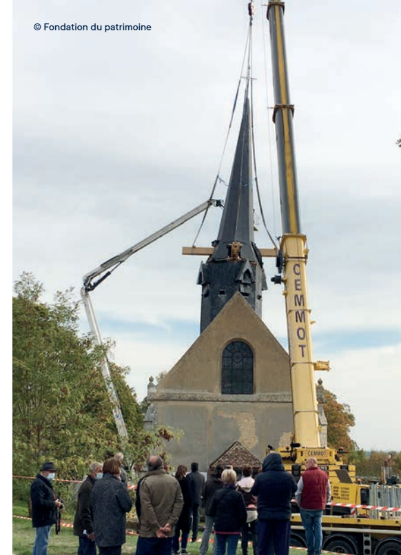
Dépose de la flèche de l'église Saint-Eloi-Saint-Jean-Baptiste de Crécy-Couvé (Eure-et-Loir) qui penchait et menaçait de s'effondrer.
