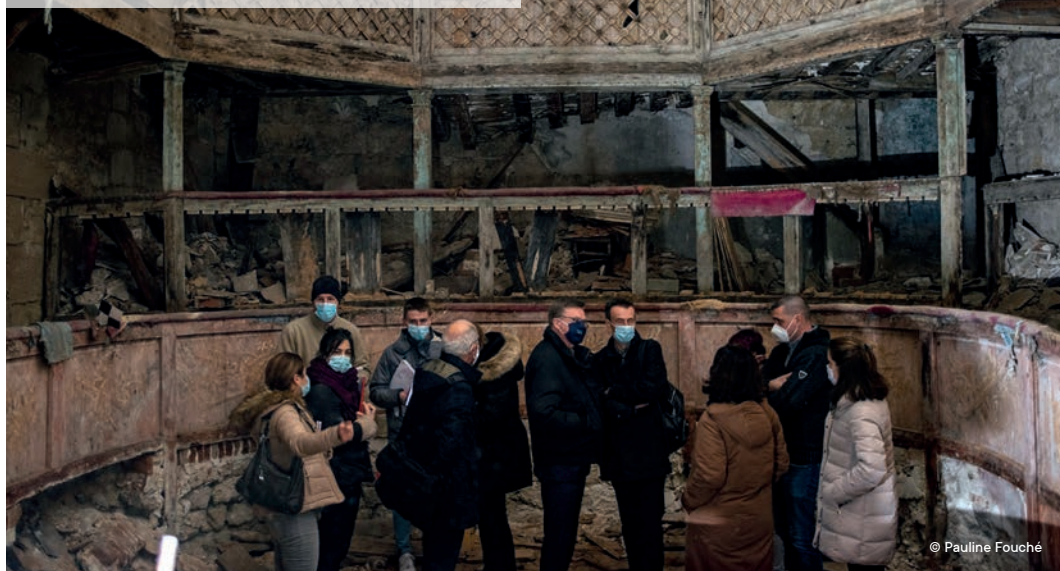
Réunion de lancement de chantier au théâtre du château de la Roche-Guyon (Val-d'Oise). Cet exemple rare de théâtre aristocratique du XVIII e siècle se trouve aujourd'hui dans un état de délabrement avancé, en raison de la situation souterraine et en partie troglodytique du théâtre.
